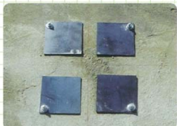
固定版取付完了
