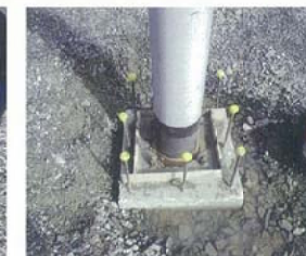
アンカーボルトへの張力導入作業
