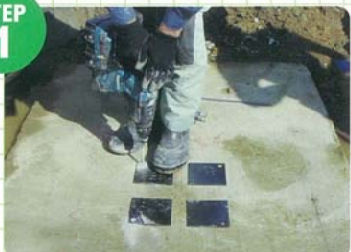
固定板取付作業
