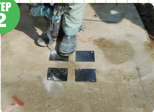
固定板取付作業
